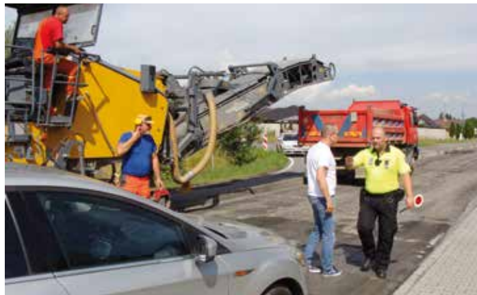
Stavba kruhového objezdu ve Sviadnově již začala, strážníci měli plné ruce práce
