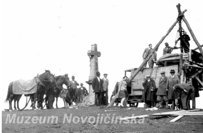
Instalace sousoší sv. Cyrila a Metoděje od sochaře Albína Poláška na Radhošti, září 1930
