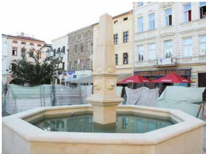
V posledních srpnových dnech byla nová kašna ještě obestavěna zábranami
