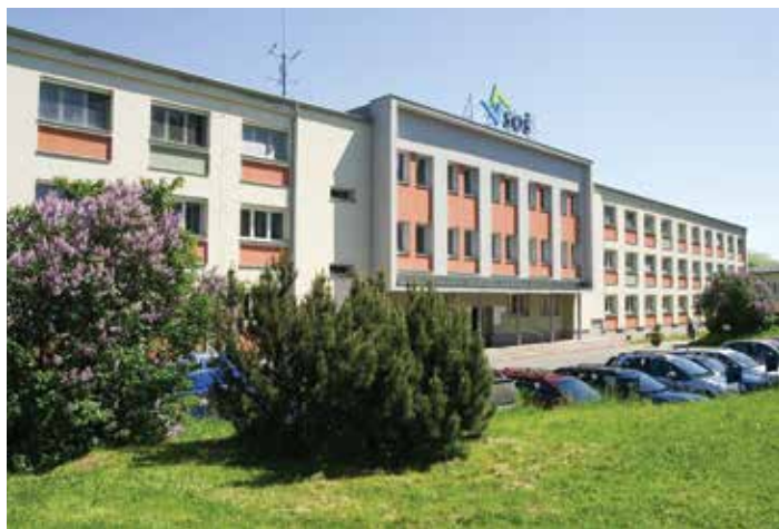
SOŠ na ulici Lískovecká
