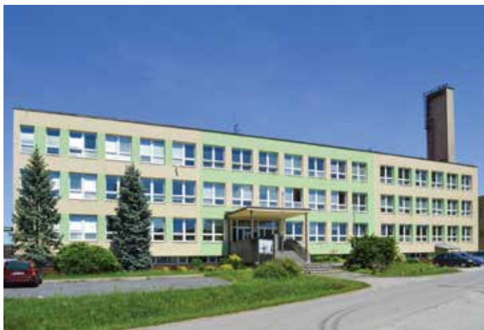
Budova SOŠ Na Hrázi
