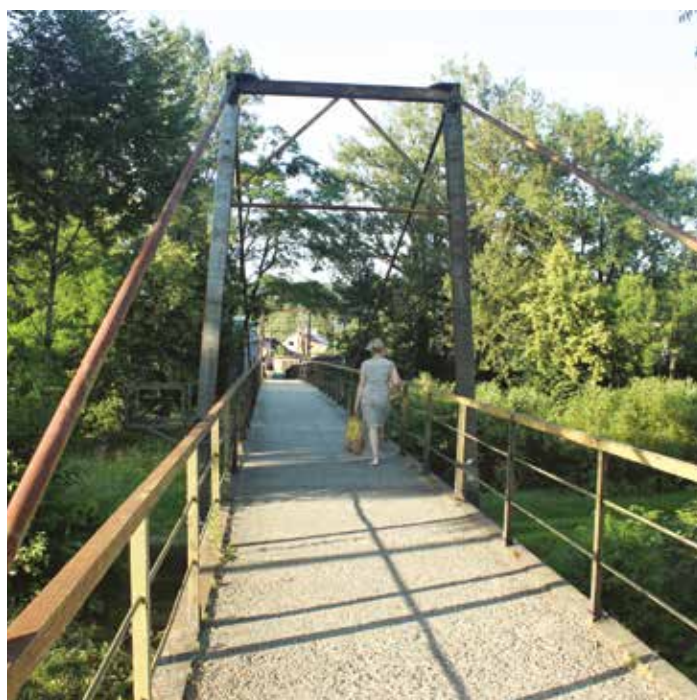
Po rekonstrukci získá lávka do Sviadnova žlutou barvu
