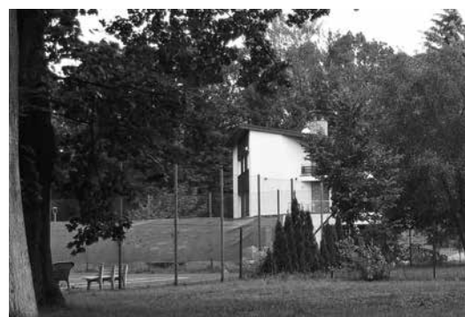
Vila Dr. J. Alsterna ve Frýdlaňtě n. Ostravici byla postavena v letech 1939–1940 Foto | Petr Juřák
