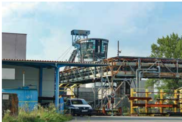
Zatímco zakulacená věž nad výdušnou jámou zůstane zachována, věž nad vtažnou jámou má být zbourána
