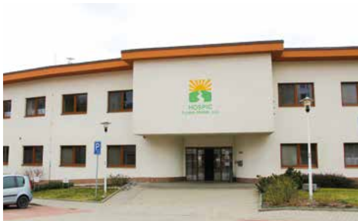
Klienti hospice ve Frýdku-Místku se dočkají klimatizovaných prostor.
