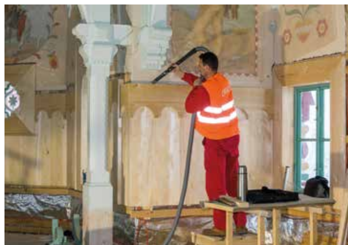
Práce v interiéru nadále pokračují.
