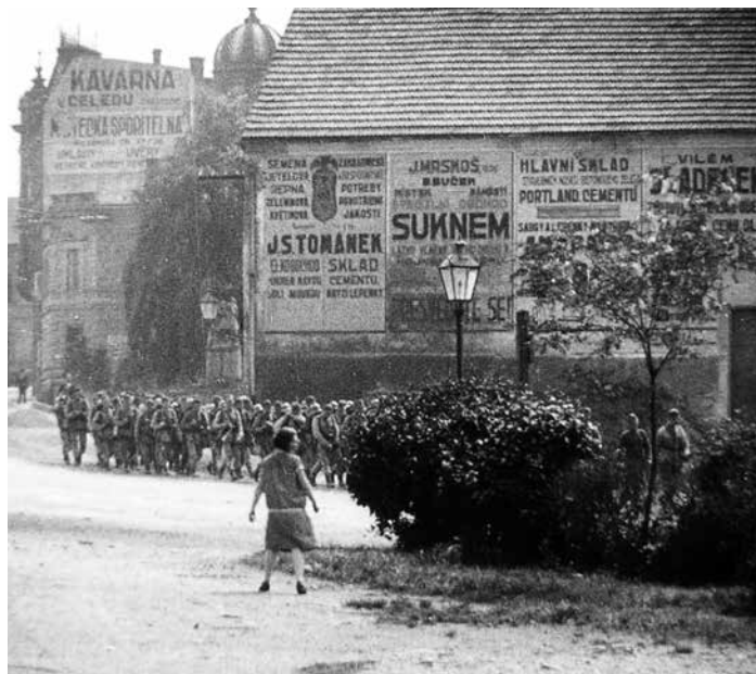
Bývalá pivovarská ledovna v Místku
