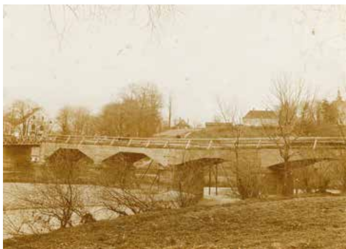
Koloredovský most přes řeku Ostravici, 90. léta 19. století
