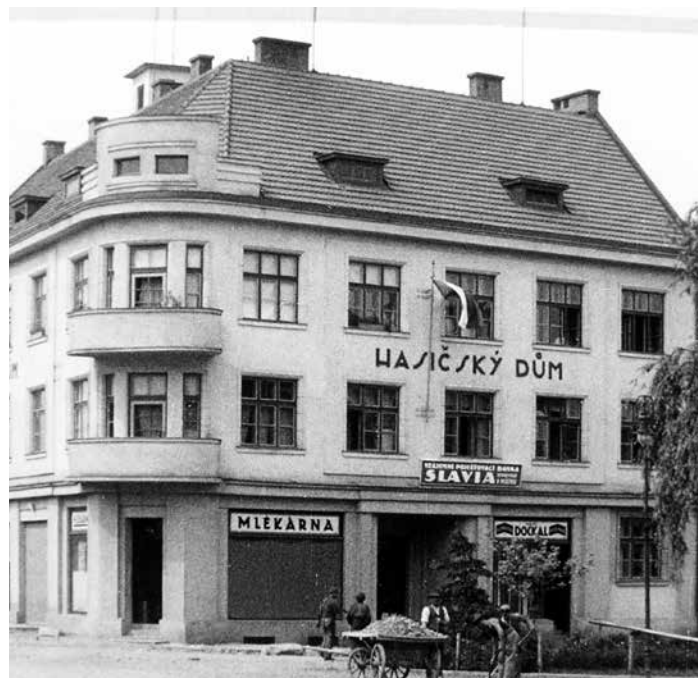
Místek, hasičský dům na místě bývalého pivovaru
