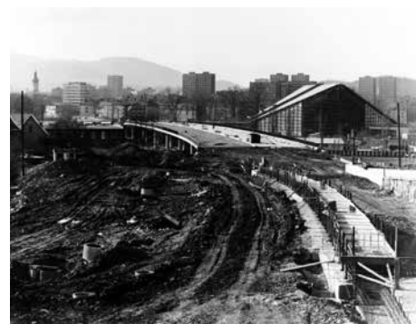
Výstavba estakády, vybouraná ulice Č. Ostravického na místě kina Slovan, 1984
