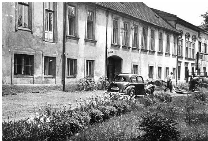
Budova bývalého panského pivovaru ve Frýdku na Podhůří.
