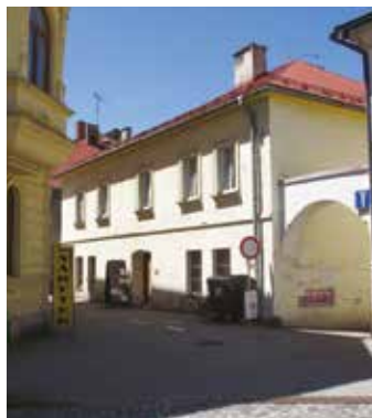
Knížecí dům v Jablunkově v roce 2020 před rekonstrukcí. Foto | Muzeum Těšínska
