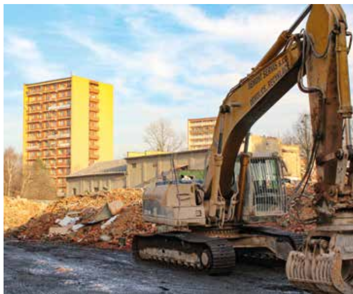
Demolice bývalé Elzerovy přádelny (Slezanu 03) na Frýdlantské ulici na přelomu let 2017–2018. Foto | 2x Jiří Sachr
